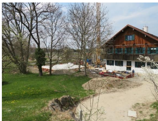
Start der Baumaßnahmen war im Frühjahr 2021: Die Bodenplatte ist bereits fertiggestellt.
