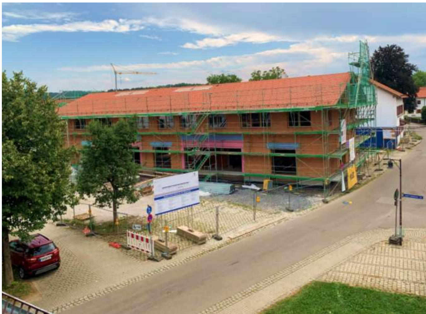
Baufortschritt Neubau Rathaus mit Bürgersaal
