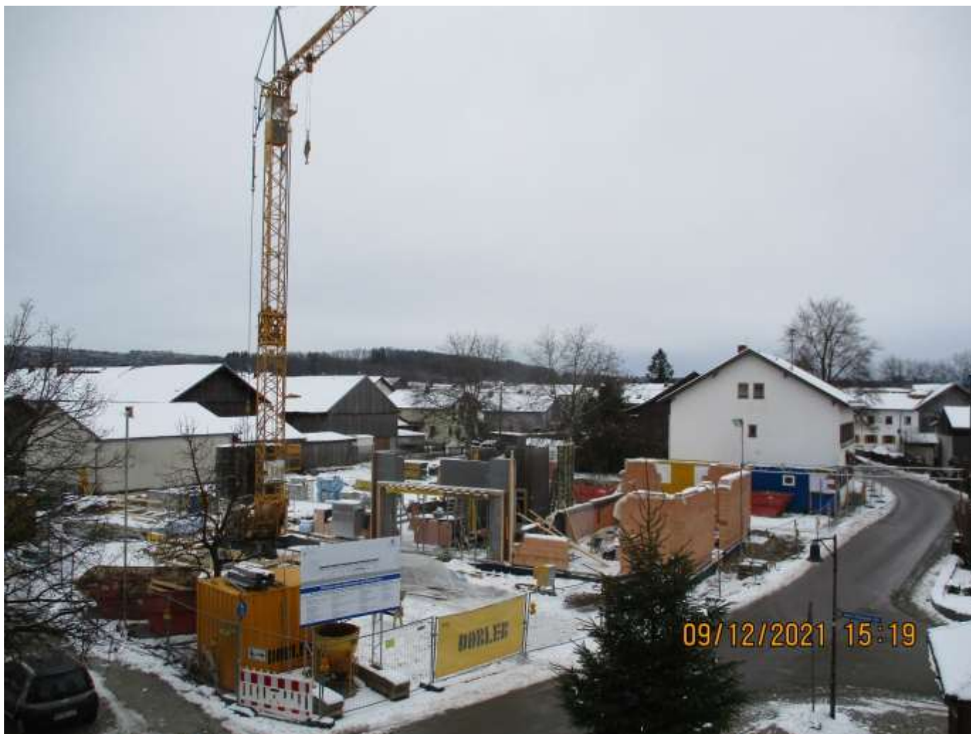
Baufortschritt Neubau Rathaus mit Bürgersaal
