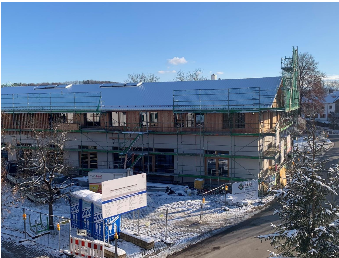
Baufortschritt Neubau Rathaus mit Bürgersaal
