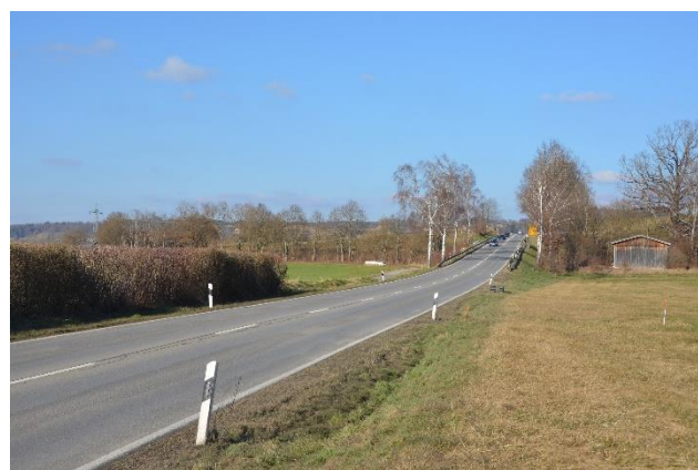
B2 bei Wilzhofen - hier sollen 5 Fahrspuren sowie eine Brücke über die B2 gebaut werden
