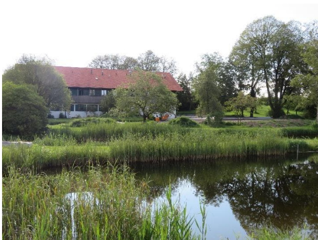
Rechts vom vorhandenen Laborgebäude entsteht aus westlicher Richtung gesehen der Neubau.
