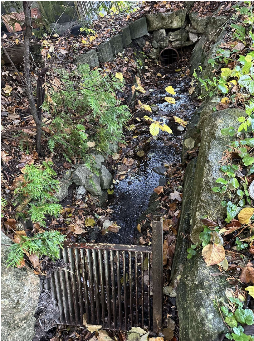
Abbildung 8: Graben inkl. Rechen und Verrohrung im Norden des Bebauungsplanes
